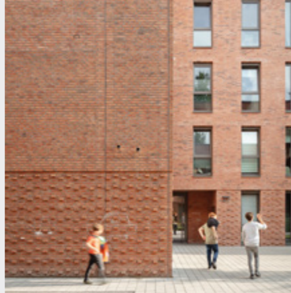
Stellingen 62 – Wohnbebauung Sportplatzring – Baufeld A, DE Architektur: Gerber Architekten, DE
