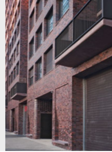
Quartier Heidestraße Core, DE Architektur: ROBERTNEUN Architekten GmbH, DE
